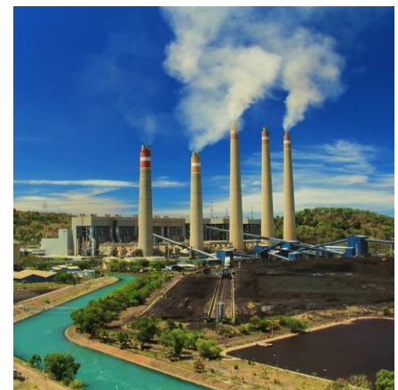
Pembangunan PLTU Nabire
